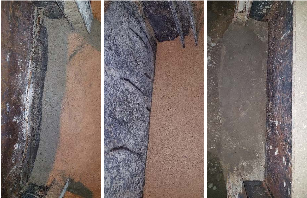
Bild 12 Bewertung des Unterkriteriums „Hohlraumverfüllung“: Exemplarische Beispiele (links), (mitte) und (rechts) jeweils ohne Auffälligkeiten
